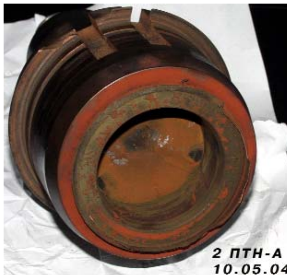
Рис. 2. Корпус подшипника и оплавленная бронзовая втулка (Сургутская ГРЭС-2)
