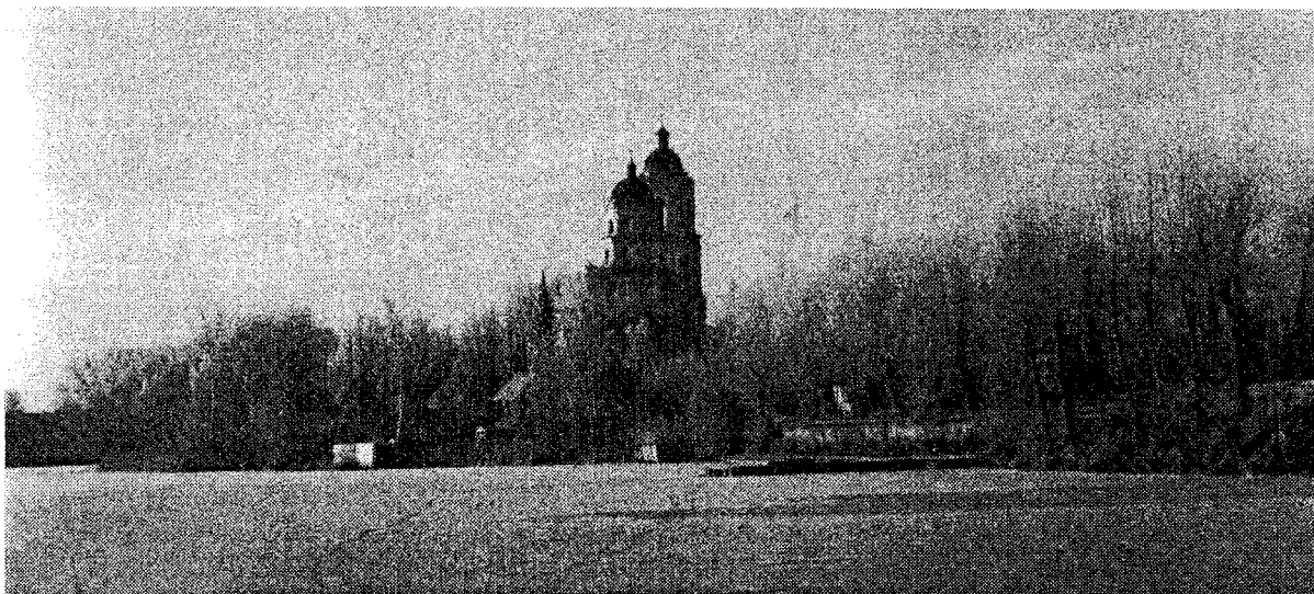
Рис. 6. Демидовская церковь XVIII в., построенная на острове. Принцип возведения центрального купола тот же самый, что и сторожевых башен, т. е. «восьмерик на четверике»
