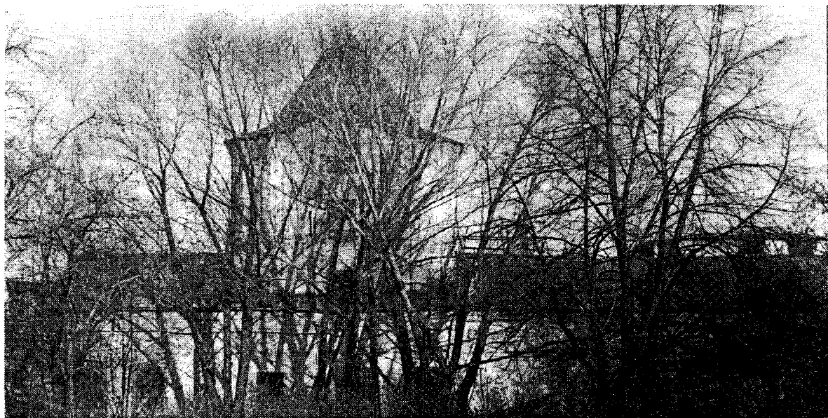
Рис. 3. Общий современный вид заводской конторы с юга
