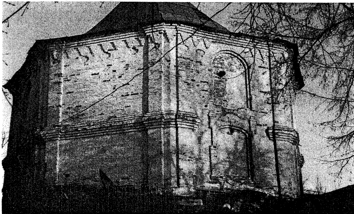
Рис. 5. Южная дозорная башня, надстроенная над каменным прямоугольным амбаром (современный вид)
